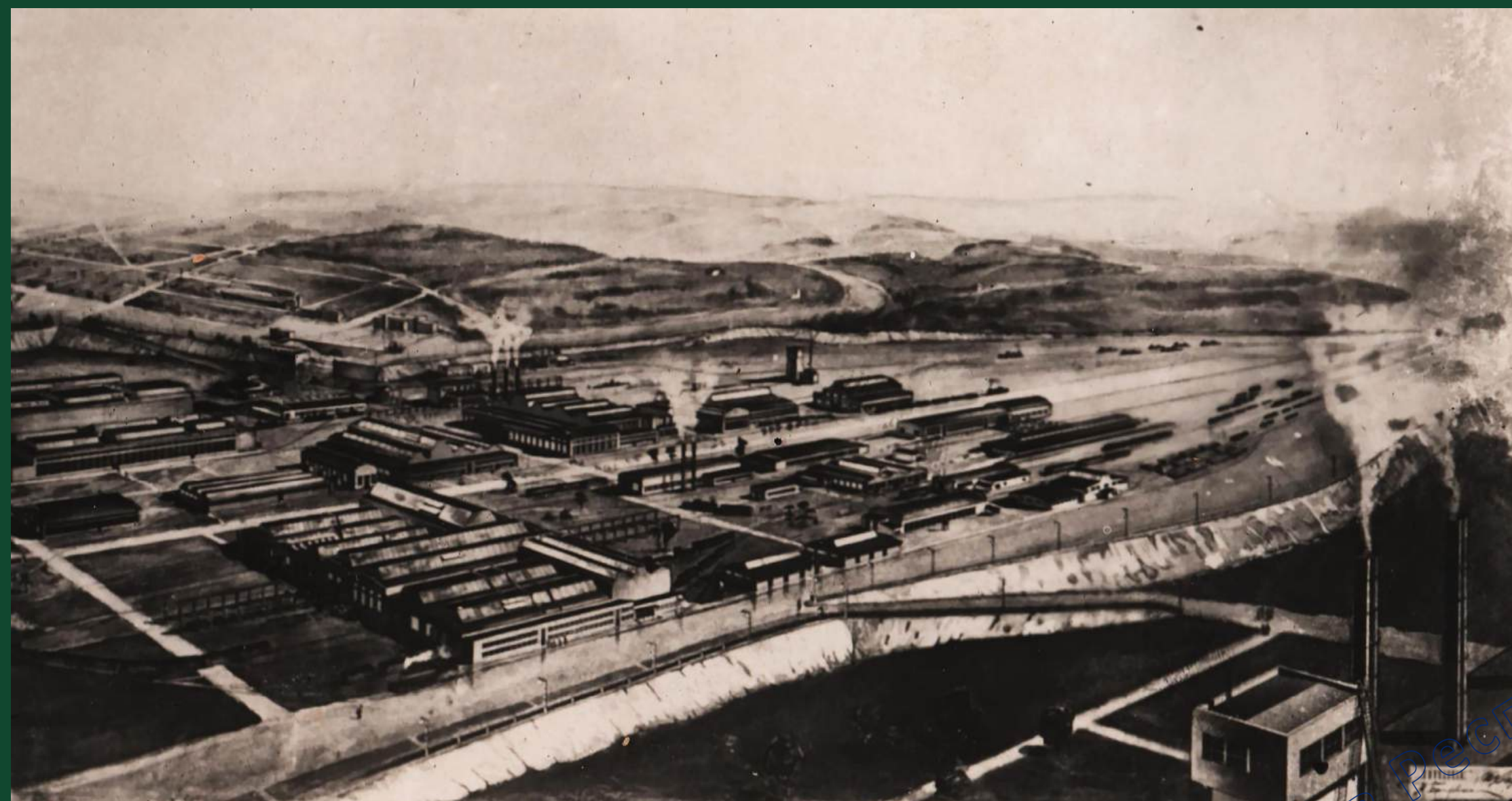
Панорама строительства ПВРЗ. Без даты. Фотофонд ГАРБ
