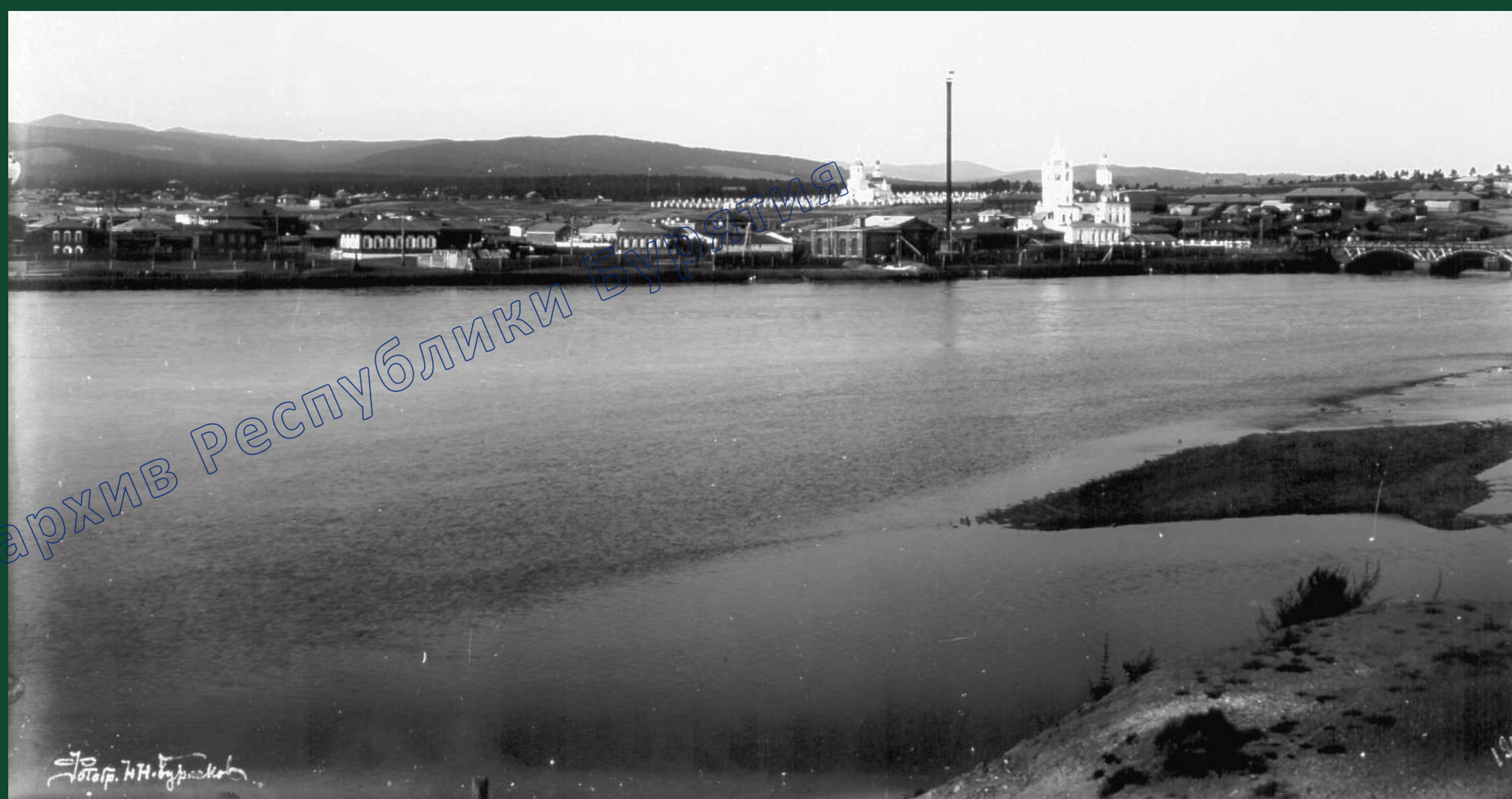
Вид на город из Зауды. На переднем плане городская электростанция. г. Верхнеудинск, 1909 г.
